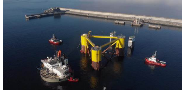
Turbinenmontage Windfloat Atlantic - Foto: EDP Renewables
